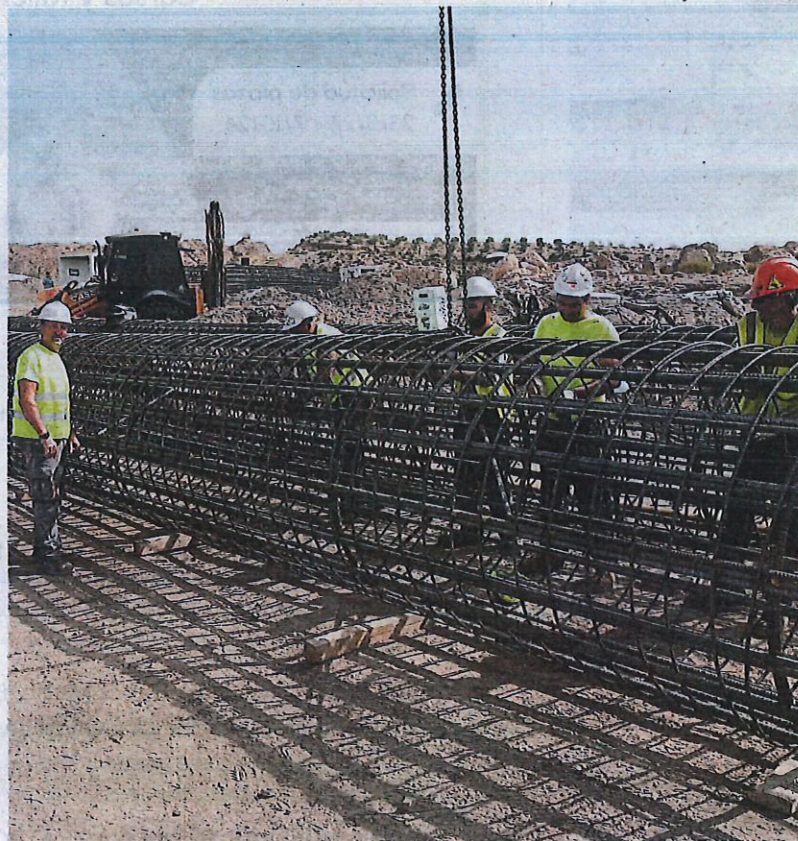
Estructura metálica utilizada en la construcción del trazado del AVE de Murcia a Almería.
